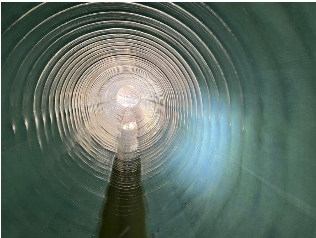
Figur 1, Renoverad dagvattenledning, Nora torg Fotograf: Simon Åkerlund
