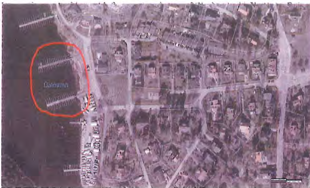
Bild 2. Befintliga pontoner som är planerade att förlängas med 17 meter respektive 22 meter.
