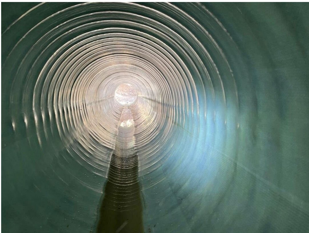
Figur 1, Renoverad dagvattenledning, Nora torg Fotograf: Simon Åkerlund
