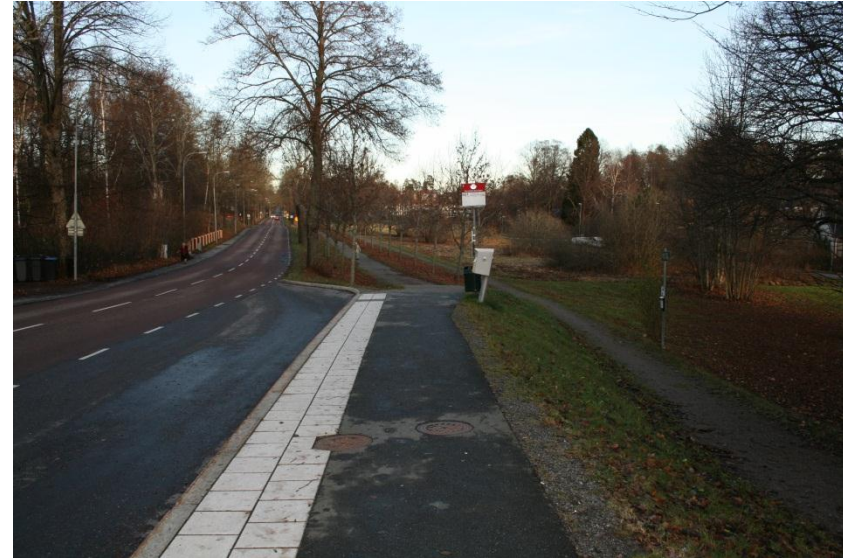
Bristfälligt utformad busshållplats
