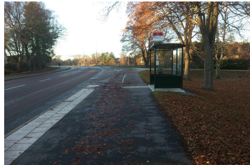
Bristfällig lokalisering på busshållplatser Vendevägen (Båda sidor)
