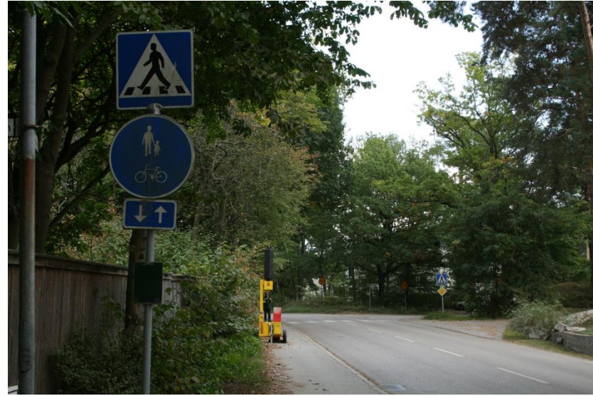
Avsnitt utmed Stockholmsvägen mellan Vasavägen och Svanholmsvägen.
