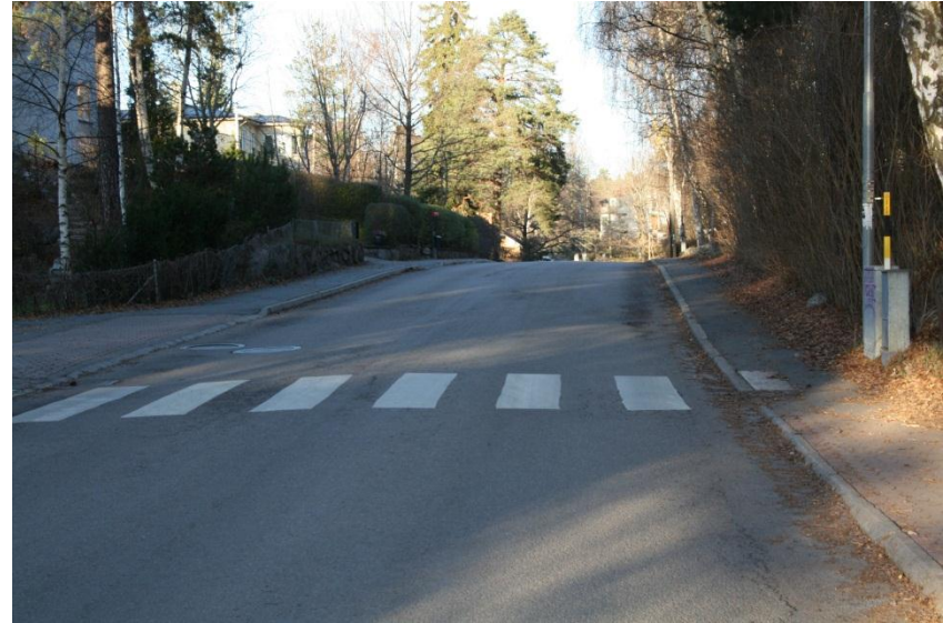
Avsaknad av GC-bana mellan Skogsviksvägen och Borgenvägen
