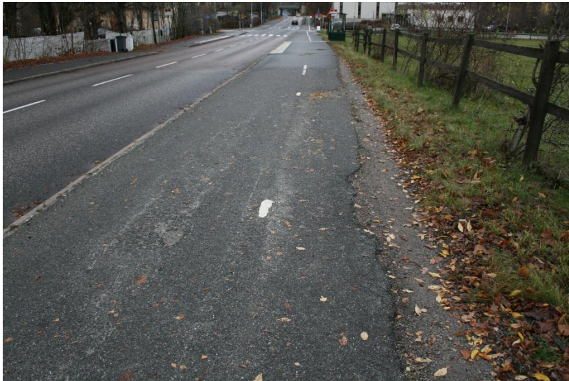
Avsnitt utmed Vendevägen mellan Angantyrvägen och Dahlbergsstigen
