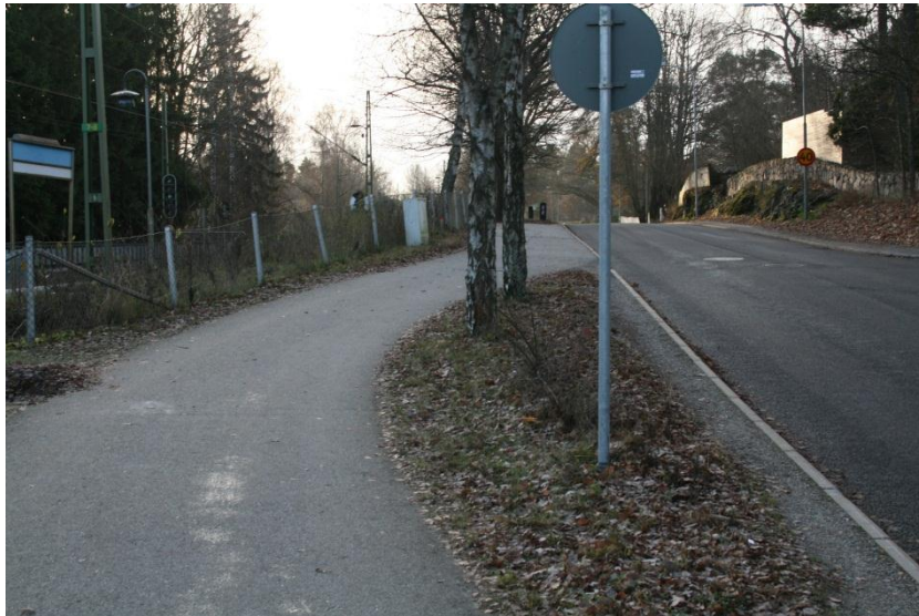
Avsnitt utmed Ösbyvägen i behov av att rätas ut
