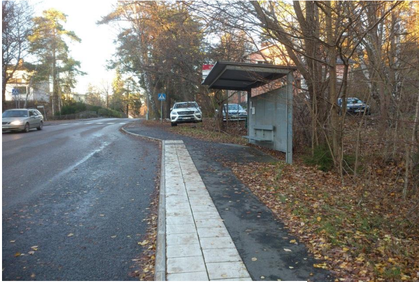
Bristfälligt utformad busshållplats
