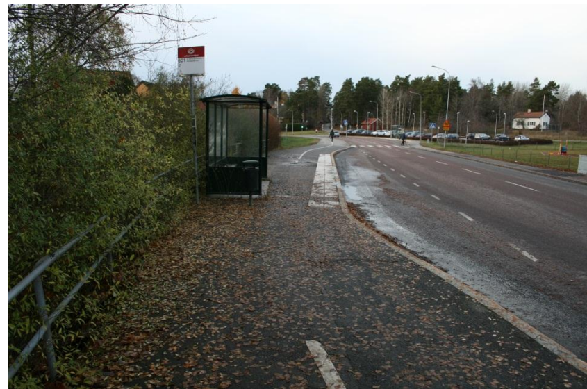
Bristfälligt utformad busshållplats
