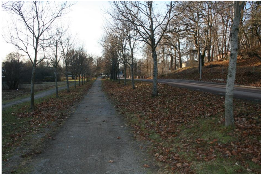
Grusunderlag samt avsaknad av belysning på GC-bana utmed Henrik Palmes allé
