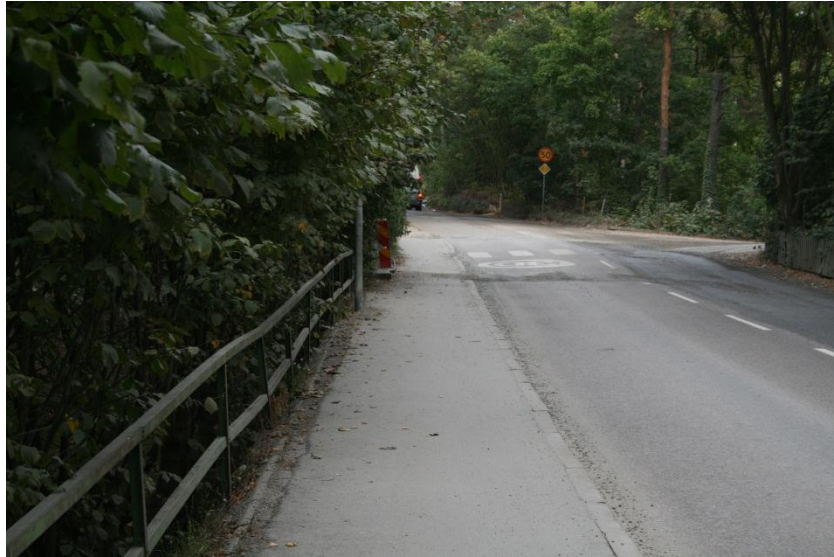
Avsnitt utmed Stockholmsvägen mellan Vasavägen och Svanholmsvägen.
