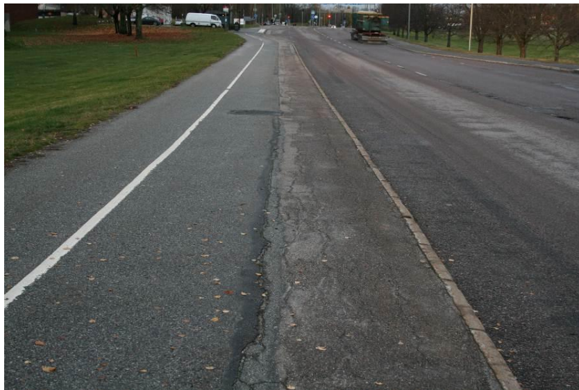
Bristfälligt underlag Enebybergsvägen mellan Skogsviksvägen och Edsbergsvägen
