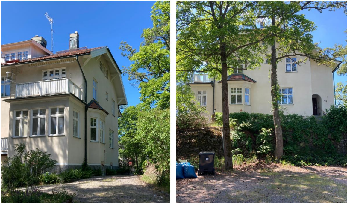
Figur 6: Till vänster: Byggnaden från Vikingavägen. Till höger: Byggnaden från Burevägen.
