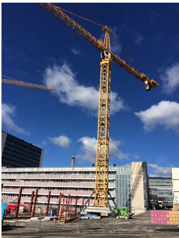
Byggarbetsplats i Danderyd
