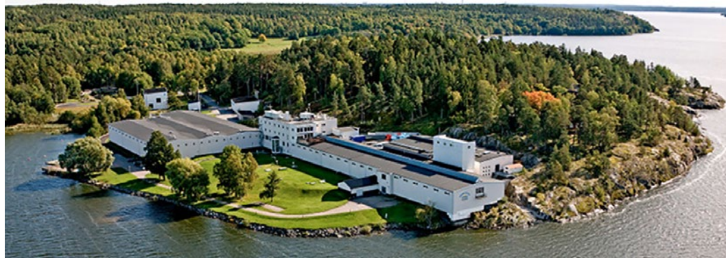
Görvälverket vid Mälaren producerar dricksvatten till ca 700 000 människor som bor i Norrvattens medlemskommuner.
